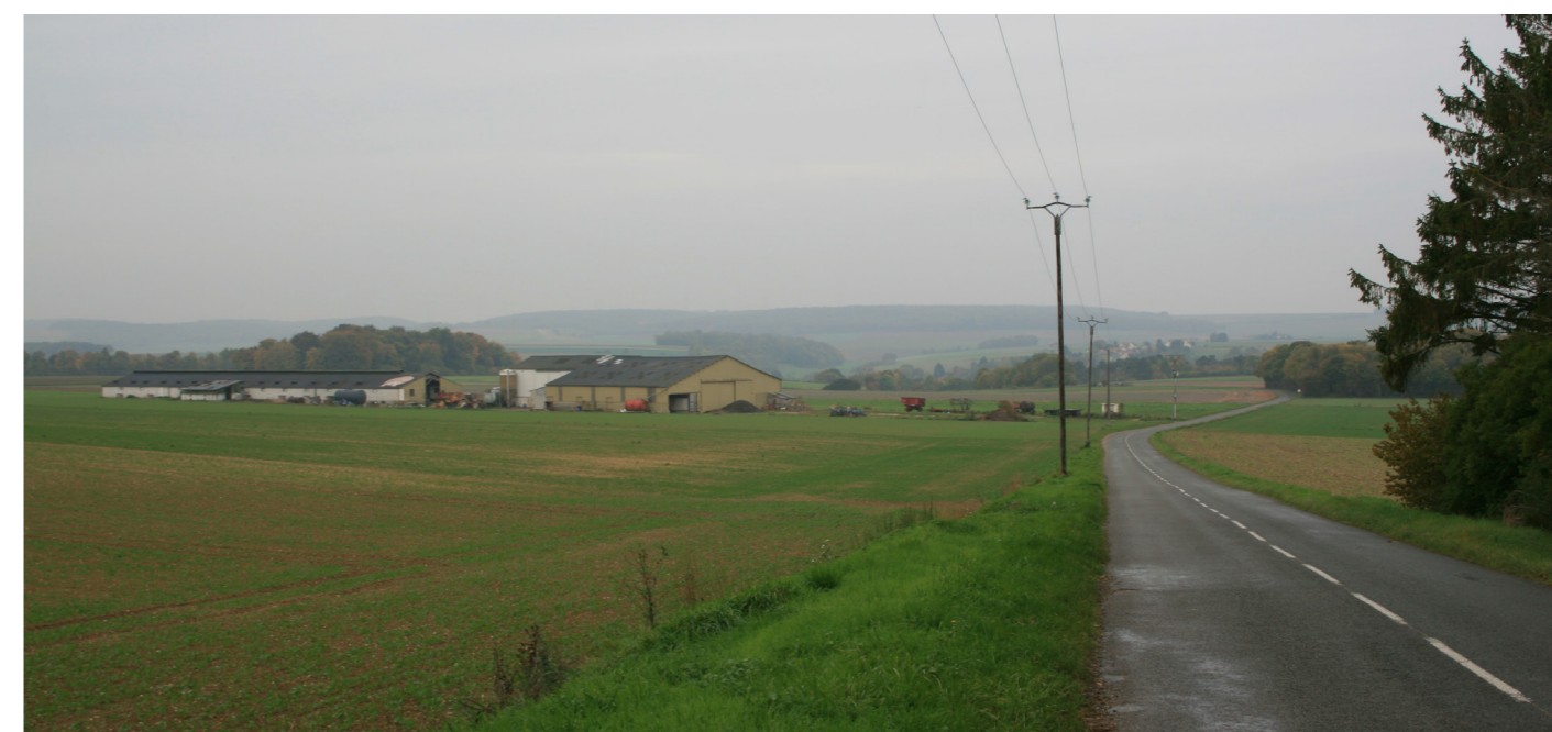
FIGURE 43 : POINT DE VUE 1. : ARRIVÉE SUR RIENCOURT PAR LA RD121
