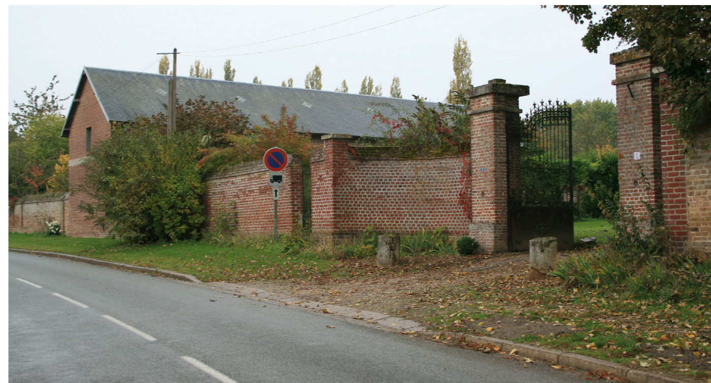
Photographie 19 : mur d'enceinte et grille d'accès à une habitation à Fourdrinoy
